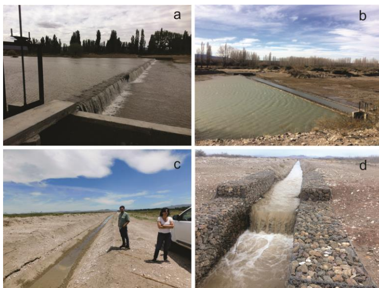
Figura 15: a) azud derivador. b) obra de captación (azud, cuenco amortiguador y toma). c) sección del canal. d) salto hidráulico.
