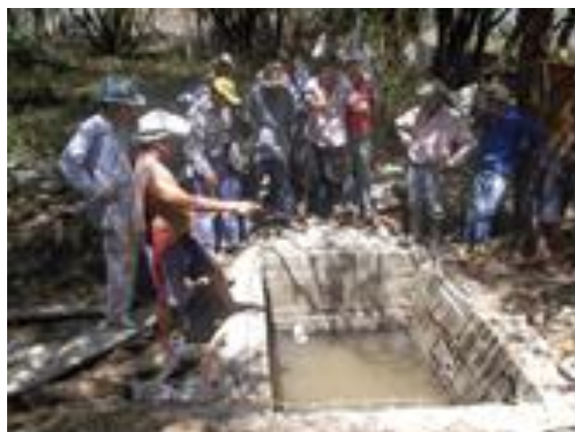
Figura 3: Protección de vertiente
