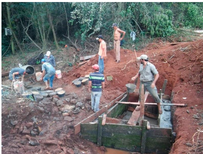
Figura 26: Protección de vertiente Misiones
