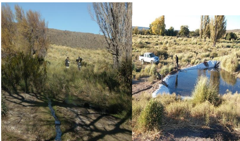
Figura 5: medición del nivel del terreno con teodolito para trazado de acequias (izquierda) y represa completa de agua funcionando como prueba piloto (derecha).
