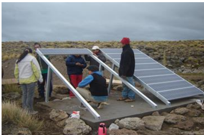
Figura 2: Instalación de los paneles solares
