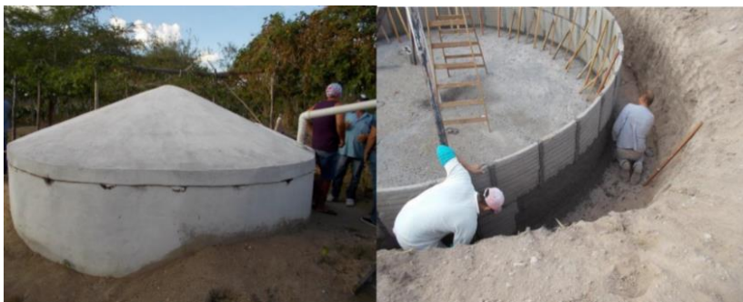
Figura 23: Instalación cisternas de placas de hormigón
