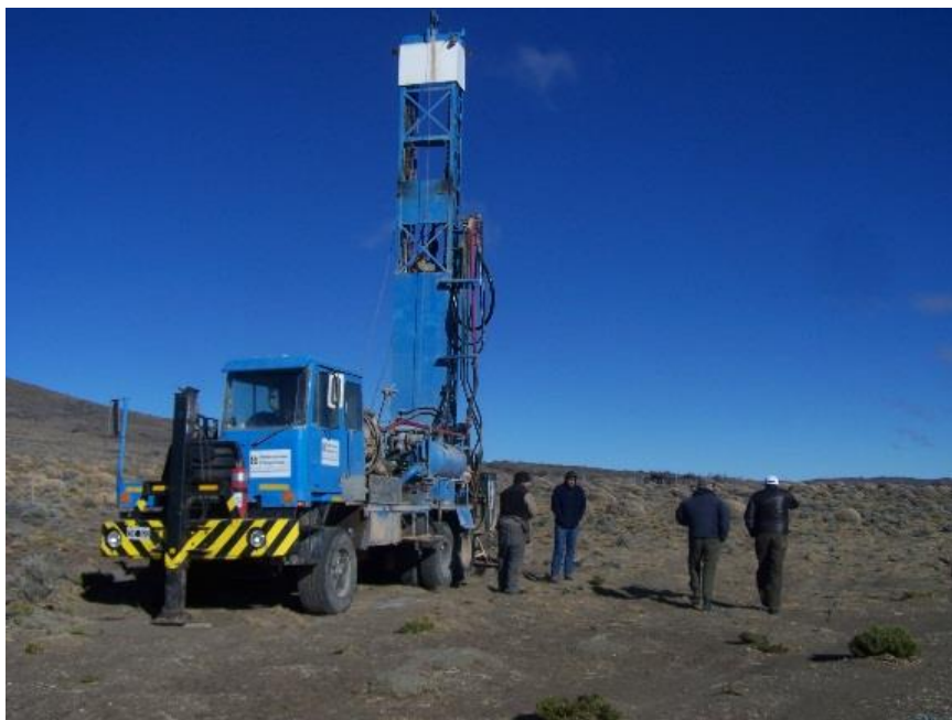
FIGURA 2: EQUIPO DE PERFORACIÓN
