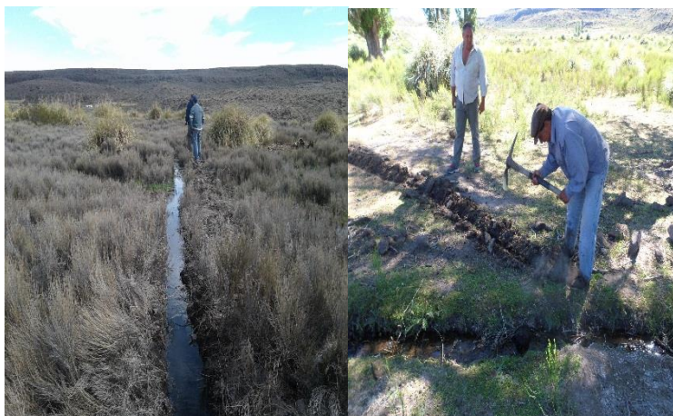
Figura 6: agua en los canales sobre el mallín (izquierda) y realización de canales con pala y pico (derecha).
