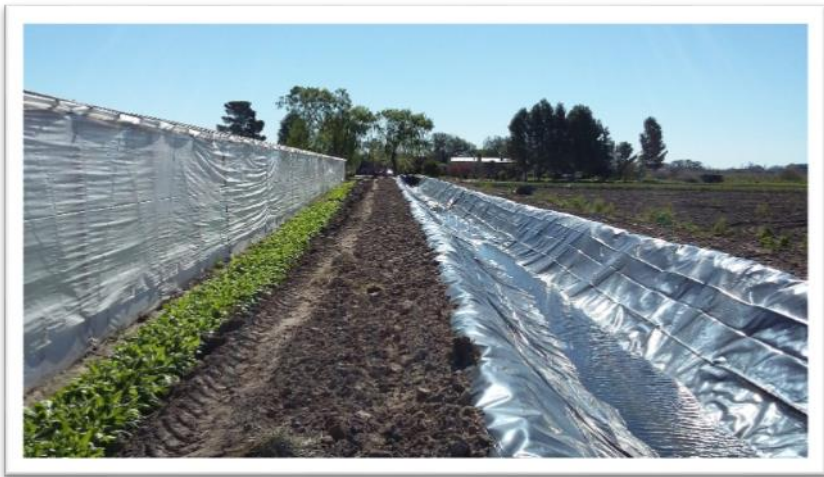
Figura 6: Acequia interna ensanchada, profundizada y revestida convertida en reservorio.
