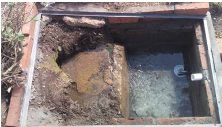
Figura 3: Obra de captación de vertiente.
