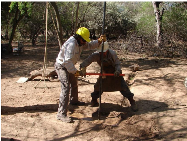
Figura 25: Construcción de perforación.
