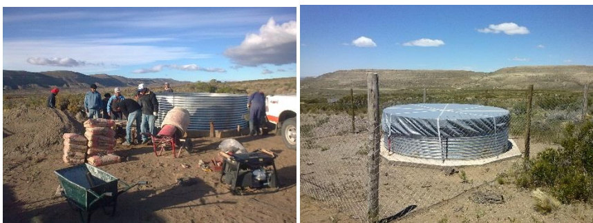
Figura 4: Armandó el tanque (izquierda). Tanque de 4 chapas terminado (derecha).
