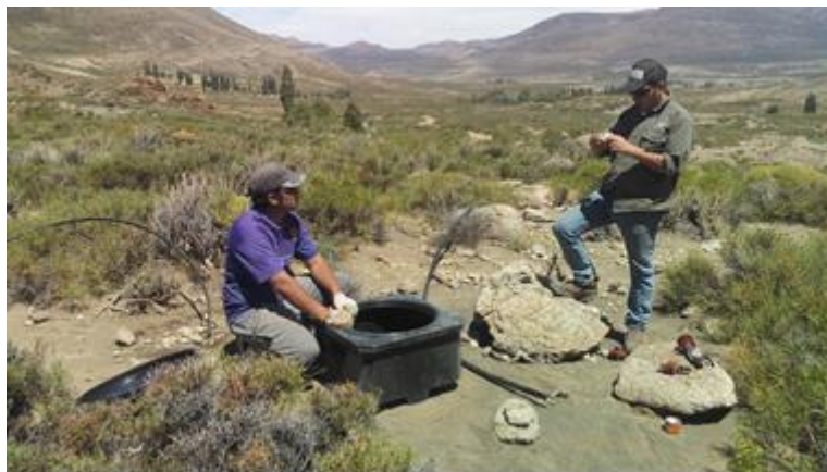
Figura 5: Armado del sistema de conducción de agua.
