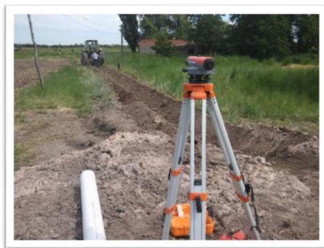
Figura 5: Tareas de nivelación con nivel de anteojo marca Pentax AL -321 32x.
