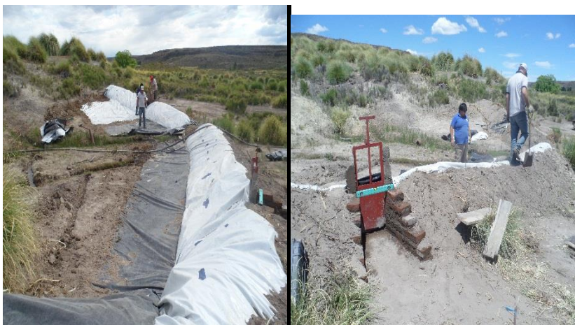
Figura 4: impermeabilización de la represa (izquierda) y construcción de compuertas en la represa (derecha).
