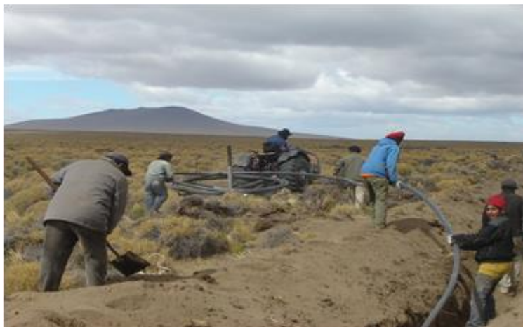
Figura 1: Trabajo en la zanja
