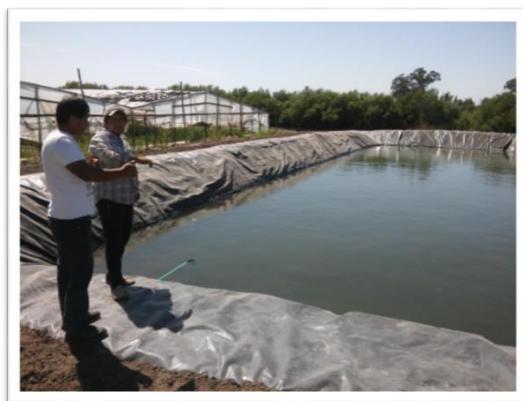
Figura 4: Reservorio terminado y en funcionamiento.
