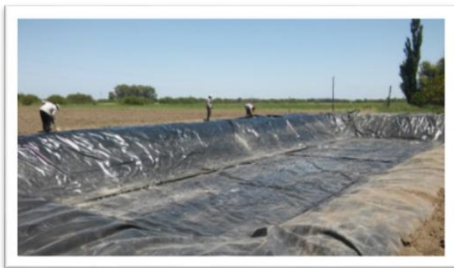
Figura 2: Revestimiento de reservorio con mantas de geomembrana de 500 micrones.
