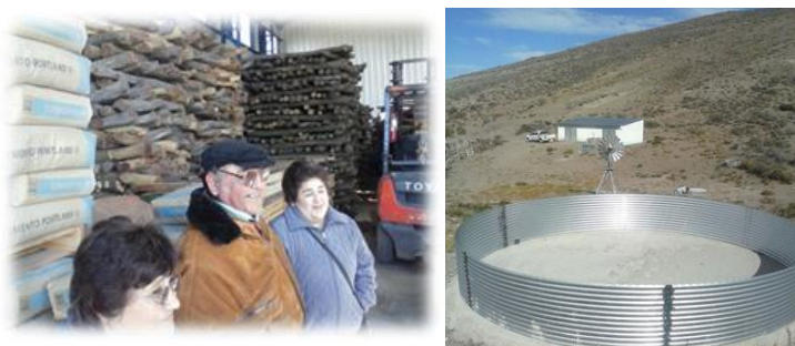
Figuras 4: Ilustración 1 Entrega de material en el Galpón de acopio (izquierda) y construcción de tanque australiano y molino (derecha)
