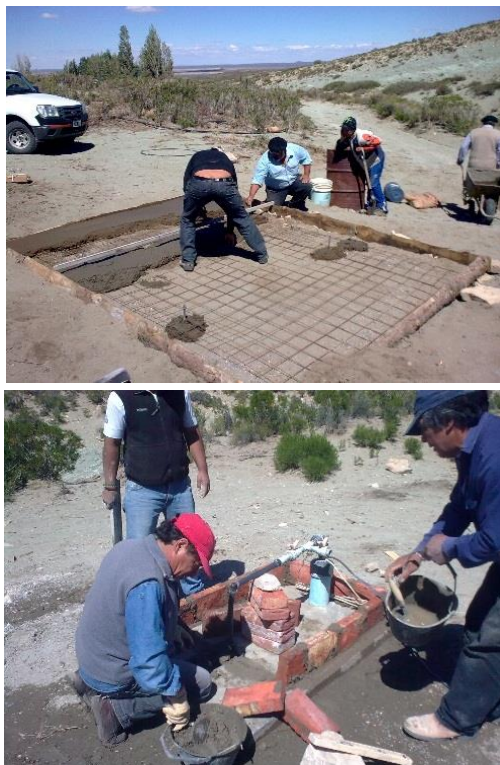
Figura 1: Platea de tanque y casilla de bombeo.
