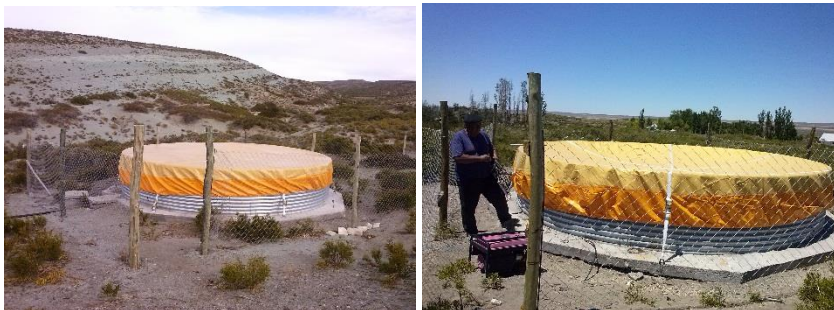
Figura 2: Tanques de 6 chapas terminados.
