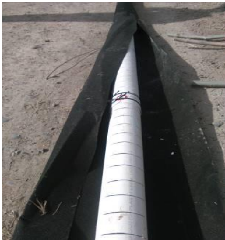
Figura 3: Construcción del dren.
